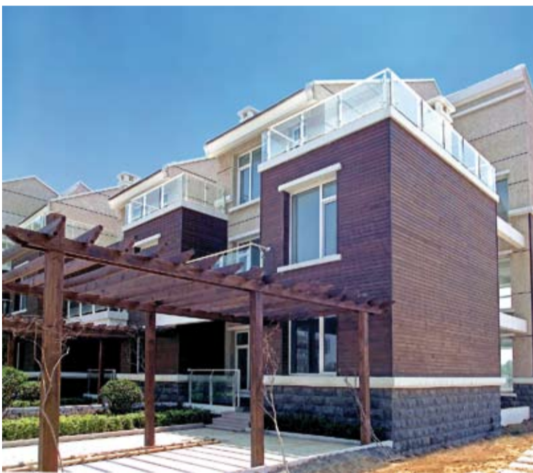
Для олимпийцев-парусников в 2008 году в городе Квингдо на Востоке Китая по проектам сингапурской архитектурной мастерской ADS была построена олимпийская деревня . Сегодня здесь проживают около 3.000 человек. Фурнитура Roto NT и профиль Veka обеспечивают функционирование 3.000 оконных створок.
